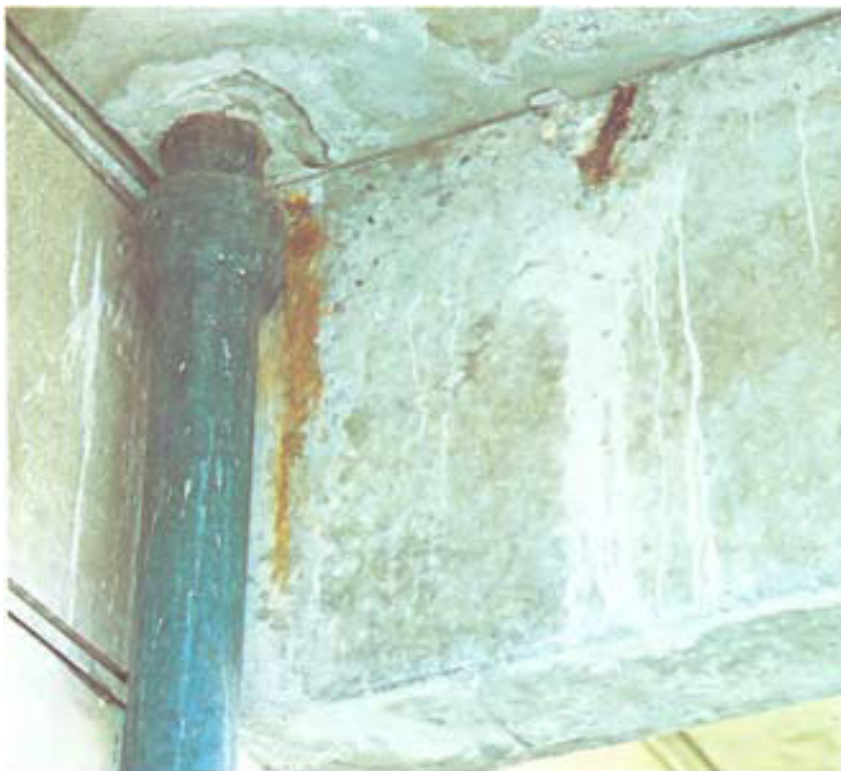
Figur 1. Vederlag under nedbrydning ved elastisk forsejlet samling.
